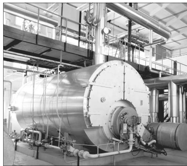
Оборудование котельной «Мамулино».
