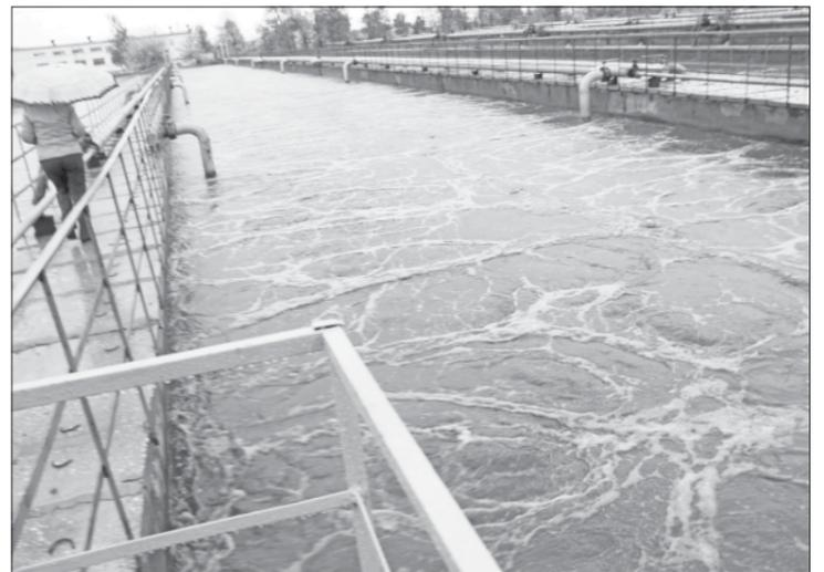
*Воды проходят биологическую очистку на аэротенках, в которых воздух перемешивает сточную воду с активным илом и насыщает ее кислородом, необходимым для жизнедеятельности бактерий.*
