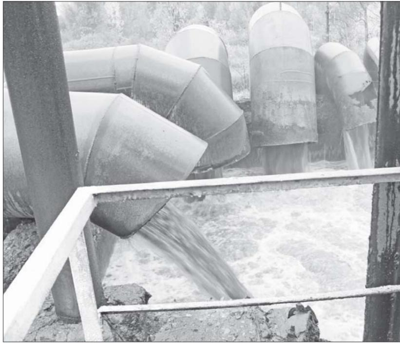
*Начало начал очистных сооружений — это приемная чаша, внушительных размеров емкость, в которую по широким трубам под большим напором поступают сточные воды со всего города.*
