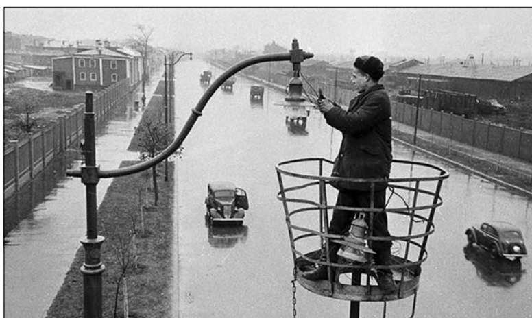
Установка уличного освещения. Фото Б. Ярославцева. 1947 год. Главархив Москвы
